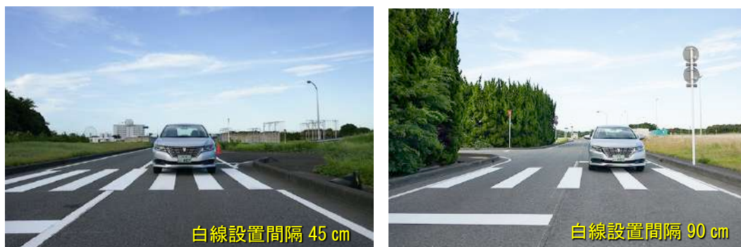
<図2-4-1 横断歩道の白線とタイヤの接地状況>
