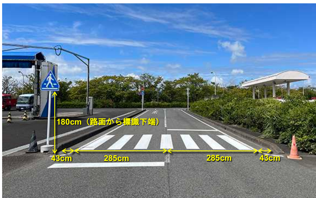
<図 3-5-5 白線設置間隔：45cm+標識 407-A（パターン 4）>
